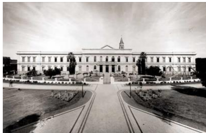
Escuela Normal n.º 1 «Dr. Nicolás Avellaneda». El edificio escolar rodeado de espacios verdes. En primer plano los jardines de la Plaza Santa Rosa, en segundo plano el ingreso a la escuela a través del gimnasio y jardín separado de plaza por el muro de circunvalación bajo y la reja. Archivo Escuela Normal n.º 1 «Dr. Nicolás Avellaneda». Rosario. Argentina.
