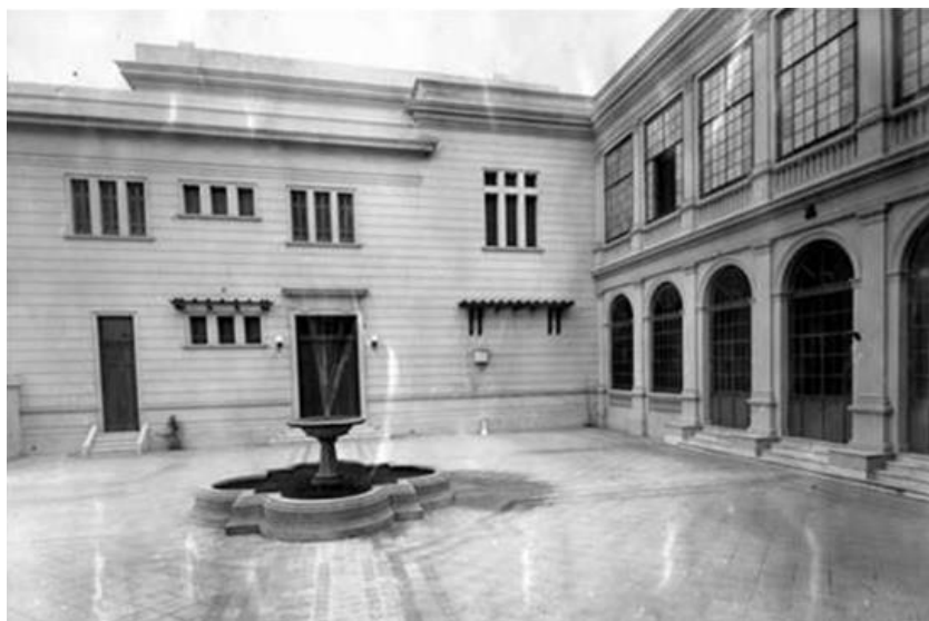
Escuela Normal N°1 «Dr. Nicolás Avellaneda». Patio interior. Para las recomendaciones higienistas de la época, carecían del asoleamiento adecuado. La fuente si bien obedecía a cuestiones de orden estético, también mostraba la presencia del agua potable dentro de la institución. Archivo Escuela Normal n.º 1 «Dr. Nicolás Avellaneda». Rosario. Argentina.
